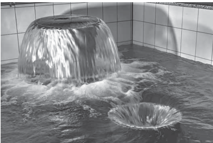
Mischkammer (Reinwasserkammer)
