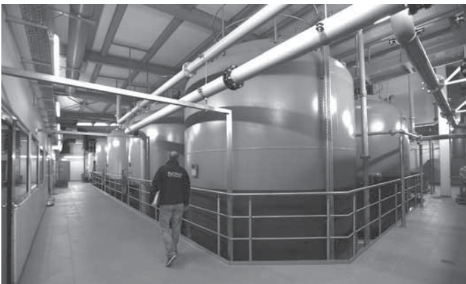
Filterhalle mit Aktivkohlefilter (grau) und CARIX-Anlage zur Wasserenthärtung (blau).
