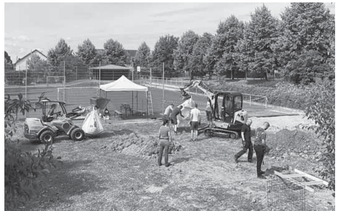
Bildunterschrift: Bauteam beim Herstellen der Fundamente
