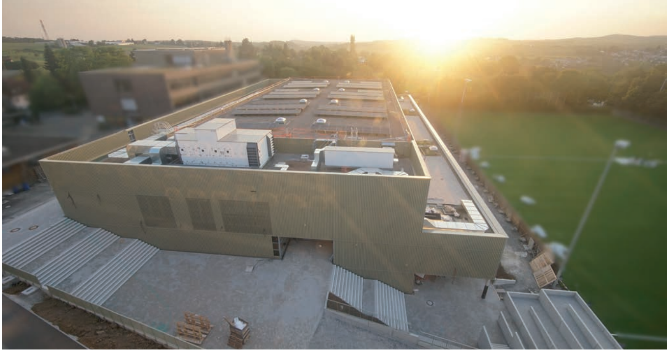
Die MURRTAL-ARENA noch im Bau von oben
