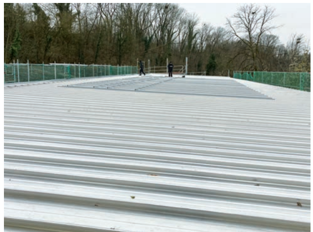
Der städtische Baubetriebshof wird mit einer PV-Anlage ausgestattet
