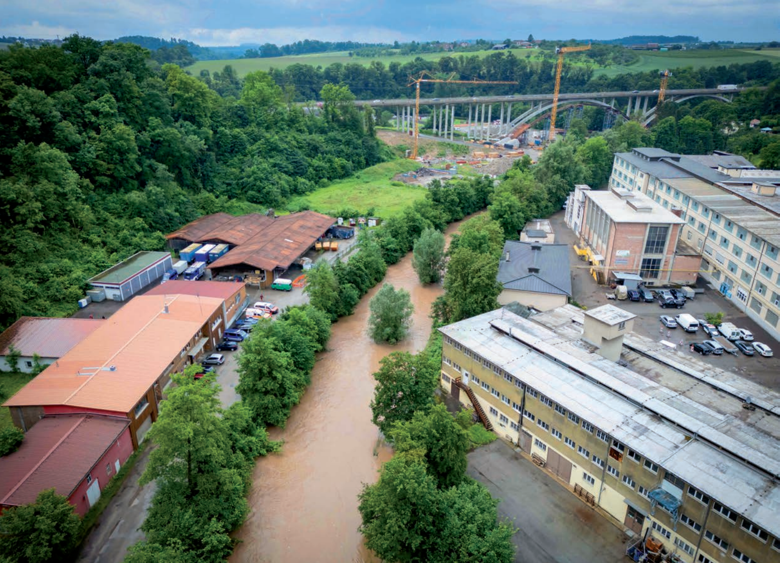
Hochwasser der Murr am 2. Juni 2024 in Backnang im Bereich der Theodor-Körner-Straße, Sicherung von umgestürzten Bäumen an der Straße
